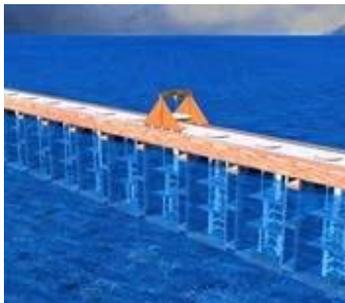
**Sistema de potencia Blue Energy** – Para la producción de Energía a gran escala, múltiples turbinas conectadas en serie para crear un cerco de marea cruzando un paraje oceánico o entrada. Son instalaciones energéticas de gran escala, diseñadas de acuerdo a las necesidades de sitios específicos que variarán en sus dimensiones y salida de acuerdo a la locación. Esta estructura tiene el beneficio adicional de que se pueden usar como soluciones de transporte.
