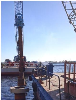
Figura 6. Movimientos a través de un sistema de Guinches que accionan los cables guías.
