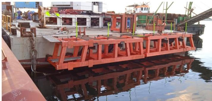
Figura 7. En el caso de los pilotes inclinados se biseca a una señal colocada en la cara frontal del cepo.
