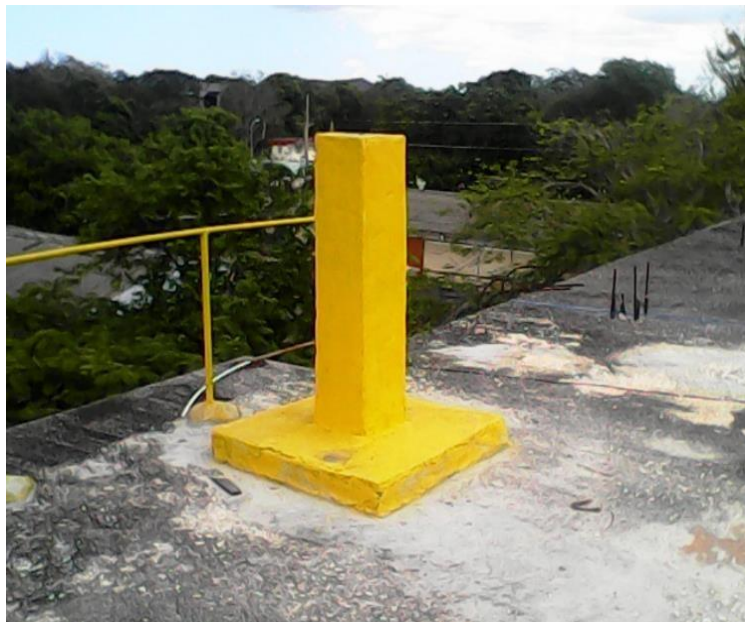
Figura 1. Pilar de centración forzada Base - 1G.
